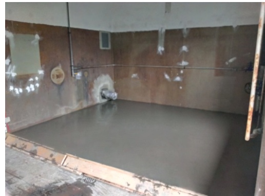
Frisch gegossenes Fundament
