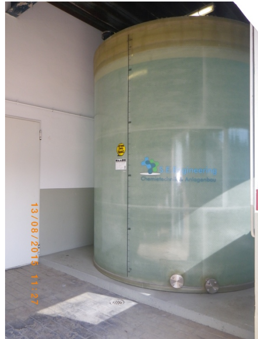
Vordere Lagerhalle mit neuem Tank
