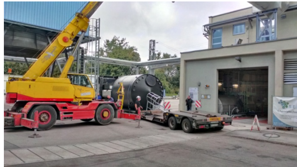
Einbringung des Tanks in die Halle
