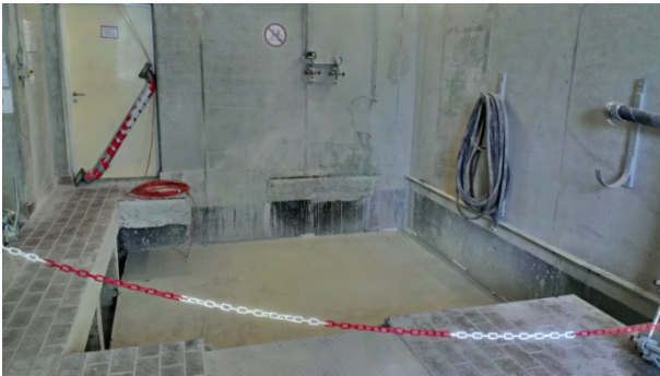
Abbruch der Rampe im Hallenbereich
